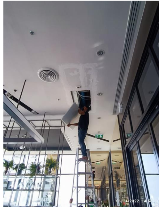
ภาพที่ 2.2-36 ล้างแผ่นกรองอากาศของเครื่องปรับอากาศในพื้นที่ส่วนกลางของอาคาร
