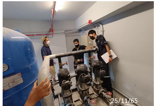
ภาพที่ 2.2-11 การตรวจสอบเส้นท่อน้ำประปา การทำงานของเครื่องสูบน้ำ และวาล์วต่างๆ
