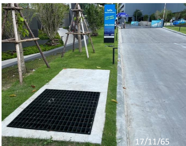
ภาพที่ 2.2-15 บ่อตรวจคุณภาพน้ำทิ้ง พร้อมตะแกรงดักขยะ
