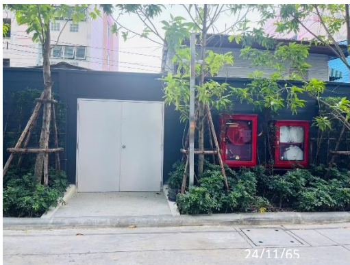
ประตูดูกเดินอพยพหนีไฟ และตู้ FHC สำหรับชาวชุมชนสะพานยาว (ด้านโครงการ)
