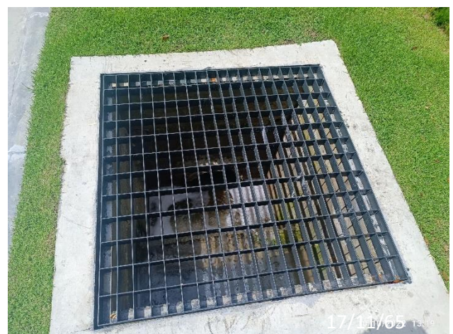
ภาพที่ 2.2-15 บ่อตรวจคุณภาพน้ำทิ้ง พร้อมตะแกรงดักขยะ
