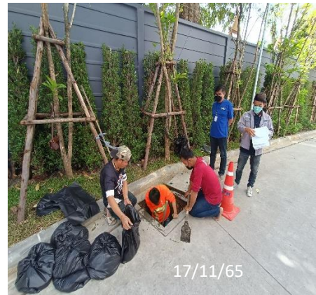
ตรวจสอบพร้อมทั้งทำความสะอาดระบบระบายน้ำ
